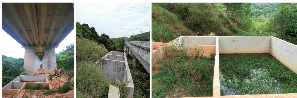
图4 海南热带雨林国家公园高速公路穿越段的道路径流处理
