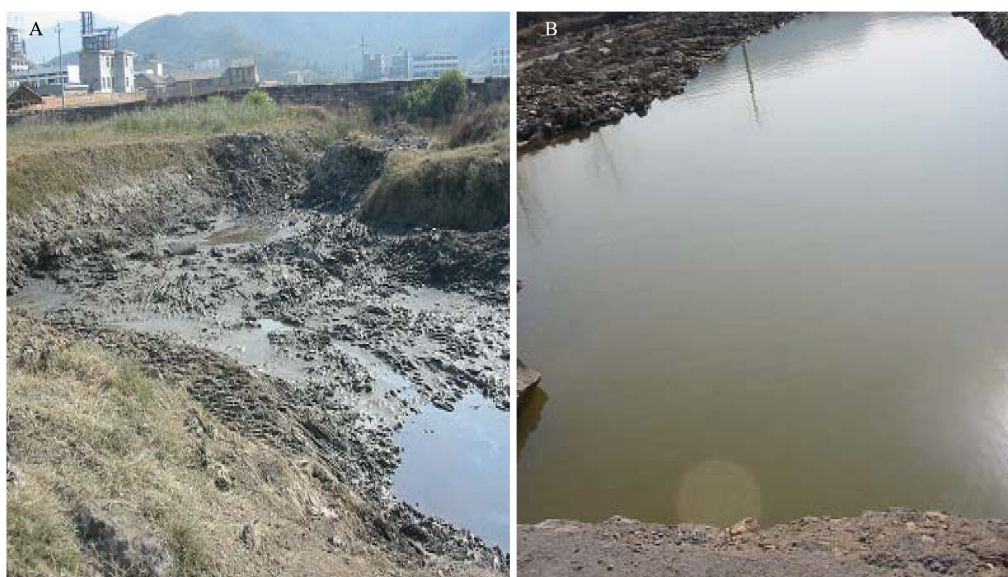
图 1 清挖后废物堆场(A)及其右侧通入海湾的水沟(B)
