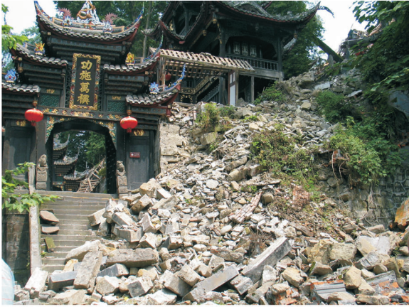
图3 二王庙山体滑坡和建筑损毁
