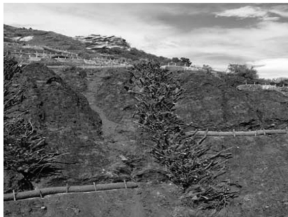
图 6 树枝填充侵蚀沟,阻止进一步下切
